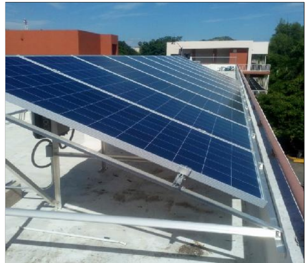
Figura 2.2: Sistema fotovoltaico UNISON.
