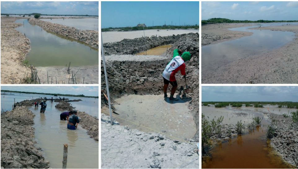
Figura 7. Ejemplos de la rehabilitación o construcción de canales en áreas de manglar degradado. Nótese que el sedimento de los bodes del canal debe dispersarse, y que la trayectoria no debe ser recta, a menos que se trate de un diseño experimental. Autor: Jorge Herrera Silveira.
