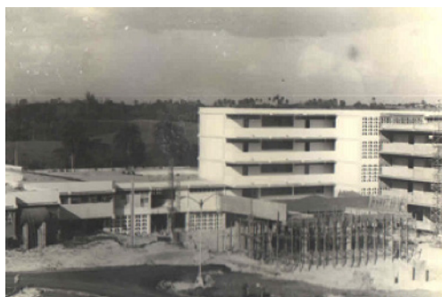
Imagen N° 8 Construcciones para el Comedor, casa de calderas de vapor, y espacios de residencia estudiantil
