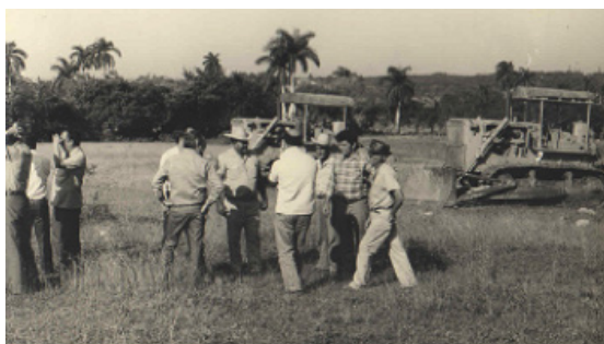
Imagen N° 6. Inicio del movimiento de tierra.
