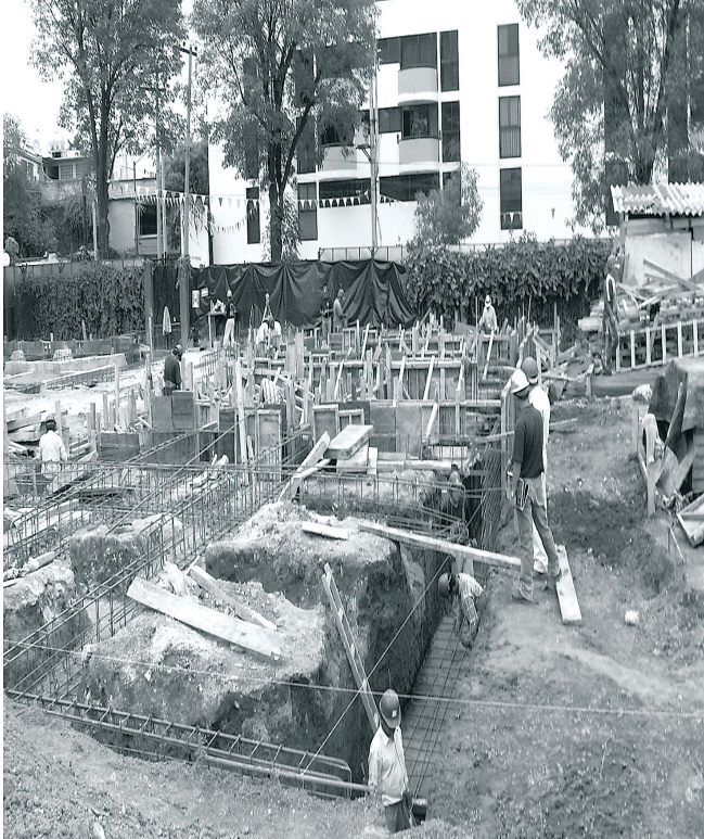
Obra: Edificio de concreto prefabricado, cimentación con base de zapatas corridas.
