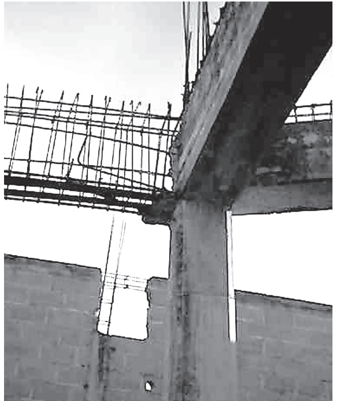
Figura 9. Corte de colado mal ubicado
