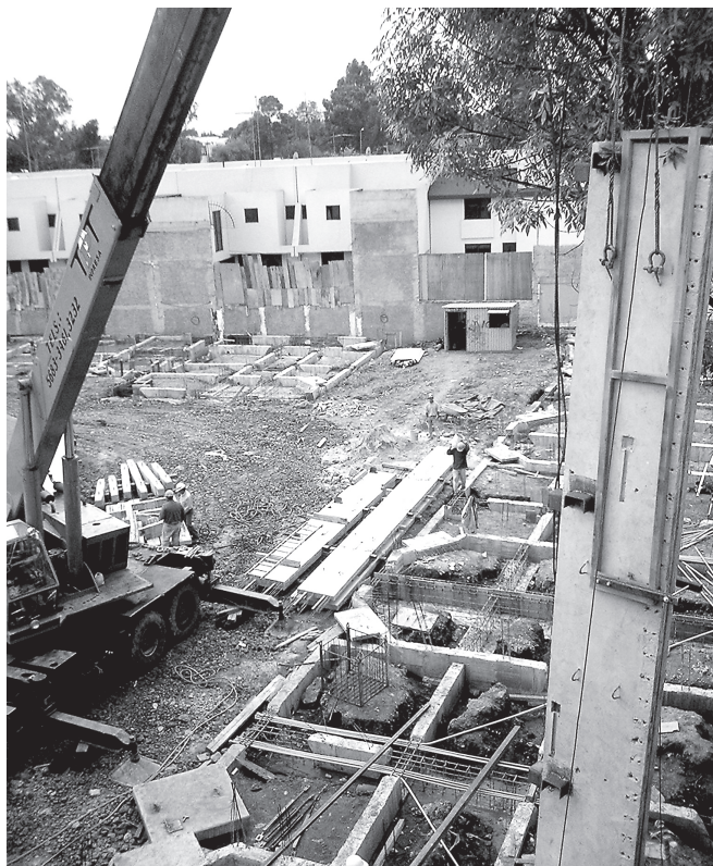
Figura 3. Corte de colado en intersecciones para recibir muros precolados.
