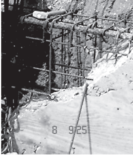
Figura 6. Corte de colado (plano potencial de falla)
